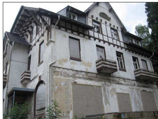
Abbildung 29 Unsanierter Burghof (Aufnahme 2013)
