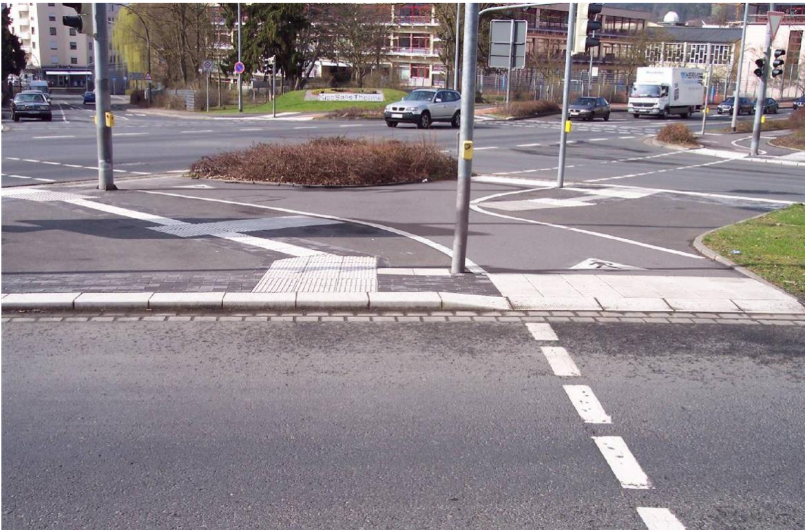
Abbildung 55: Barrierefreie Kreuzung mit normgerechter Bordsteinabsenkung und taktilen Elementen (Quelle: https://www.stmb.bayern.de/min/barrierefreiheit/ )
