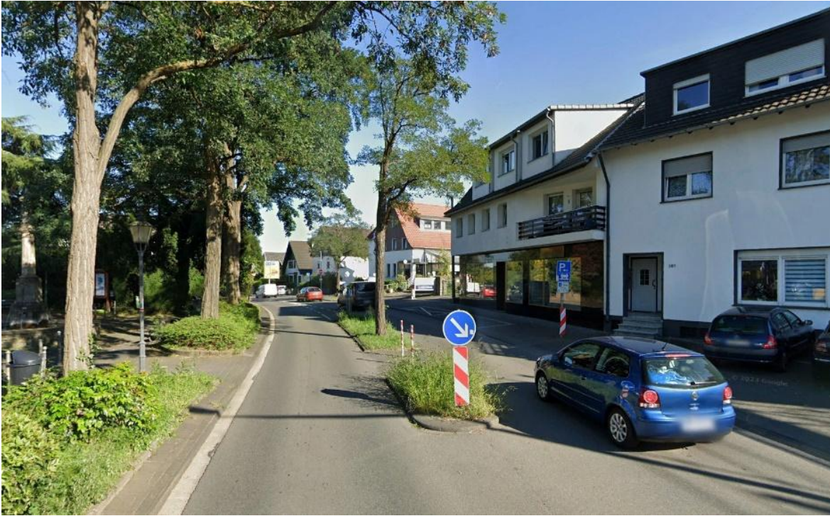
Abbildung 94: Querungsstelle ohne Bevorrechtigung des Fußverkehrs auf Höhe des Marienplatzes
