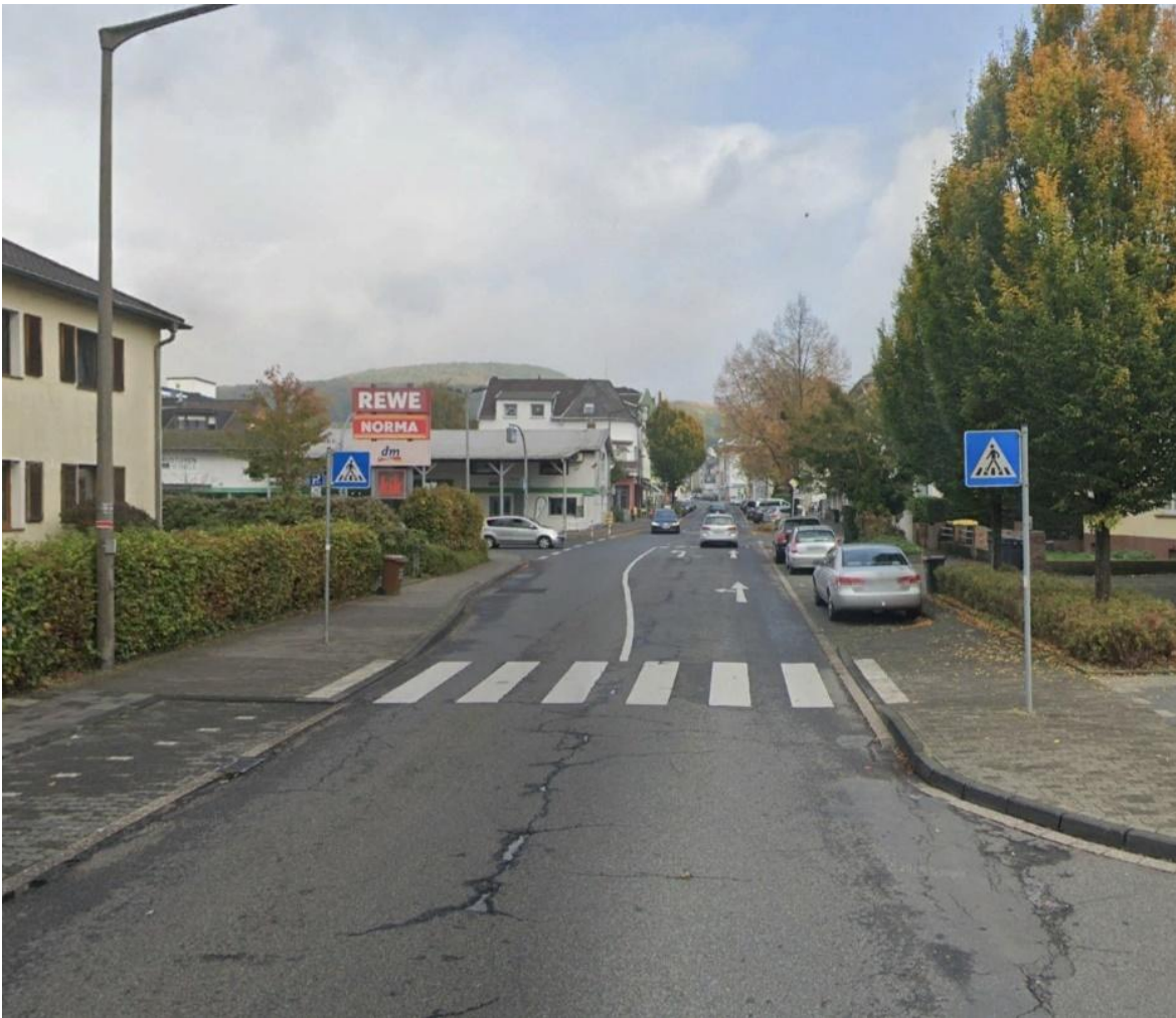
Abbildung 82: FGÜ in der Heisterbacher Straße auf Höhe der Kreissparkasse, mit Längsparker im direkten Umfeld der Aufstellfläche
