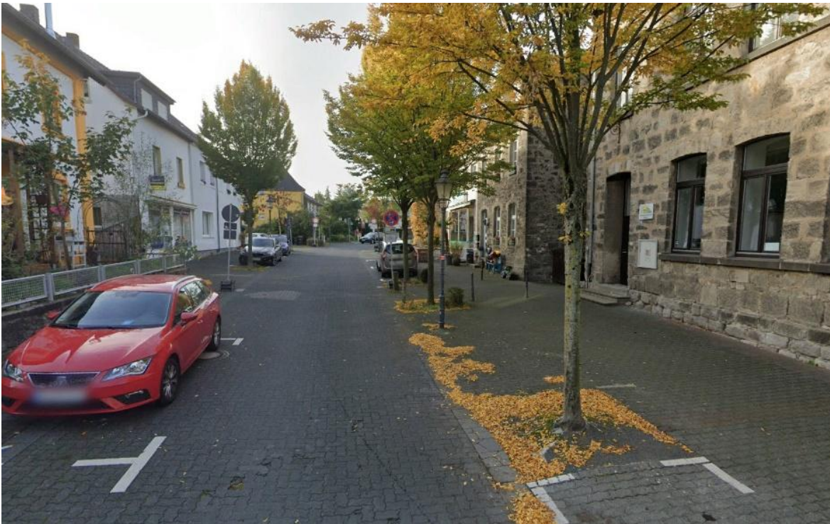
Abbildung 92: Bestandssituation in der Kirchstraße auf Höhe der Grundschule
